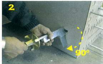
2 Selbstsicherung der UNI-Ka Auflagekonsole durch Drehung um 90°.
