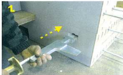
1 Einführen der UNI-Ka Auflagekonsole in die UNI-Ka Aussparung.
