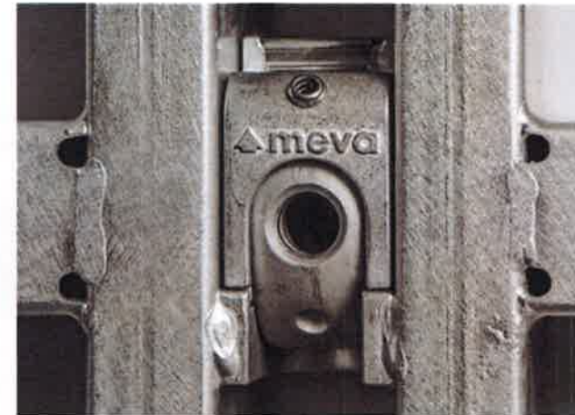
Kombi-Ankerstelle in Stellung Gewinde
